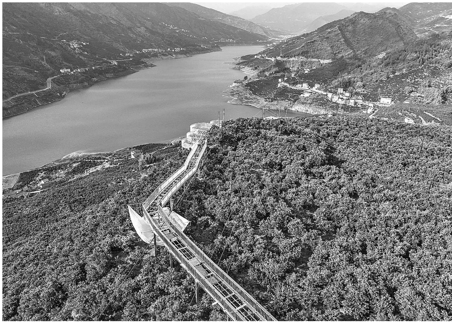
连日来,湖北省宜昌市秭归县归州镇彭家坡村吃溪河乡村振兴示范区项目工地,工人们抢抓冬闲晴好天气,在脐橙园里进行空中观光廊道、脐橙销售中转站、脐橙直播平台等工程施工。图为12月2日拍摄的空中观光廊道施工现场。
