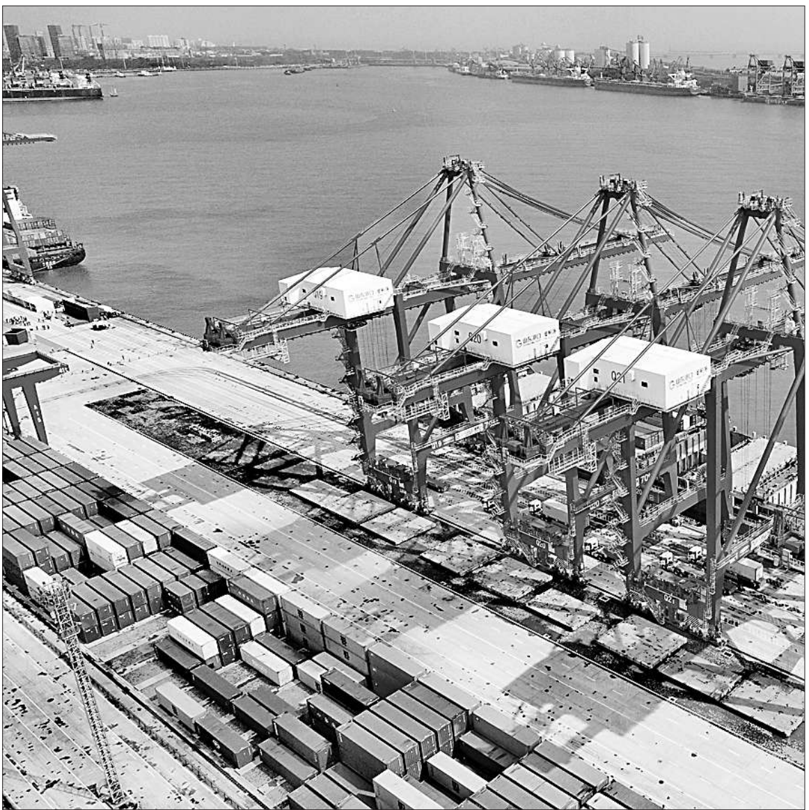
全球首个顺岸开放式全自动化集装箱码头投产运营 10月9日，山东港口日照港顺岸开放式全自动化集装箱码头投产运营。在传统码头基础上，山东港口日照港通过“自主创新+国产技术”，建成以“遥控岸桥、自动化轨道吊、无人集卡”为基本布局的全自动化集装箱码头。该码头首次将“北斗+5G”和中国国产码头操作系统TOS应用到作业全过程，实现了厘米级精度操作，综合运行成本大幅降低。 张进刚摄/光明图片
