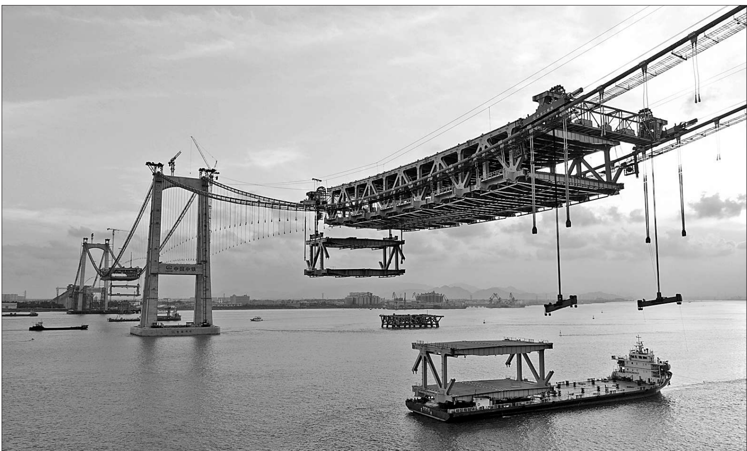
近日,浙江省温州市瓯江北口大桥加速推进项目建设,抓紧吊装加劲梁。瓯江北口大桥连接乐清市黄华与温州灵昆岛,全长7.9公里,是世界首座三塔四跨双层钢桁梁悬索桥,预计今年年底建成。图为9月4日,瓯江北口大桥正在吊装加劲梁。 蔡宽元摄/光明图片
