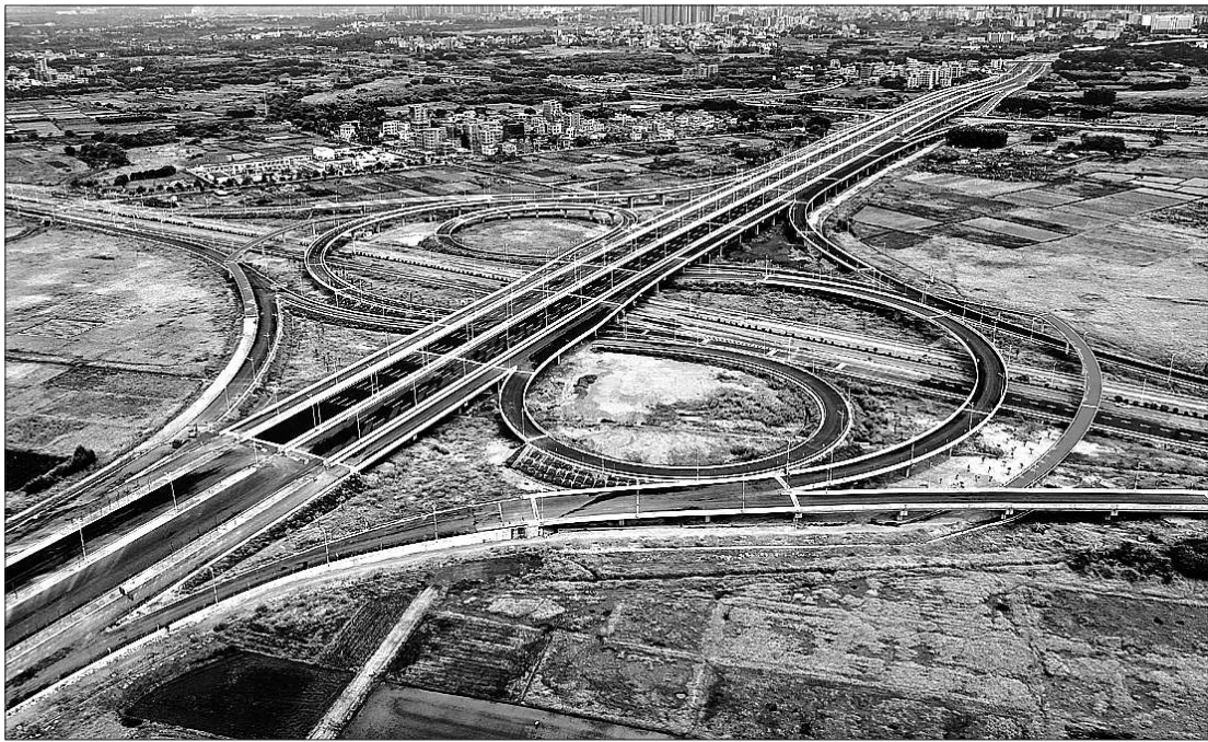
湛江大道桥梁工程即将完工 8月13日,由中建路桥集团承建的湛江大道湖光快线五通立交特大桥主体工程已完成,正在进行最后附属工程的收尾工作。湛江大道桥梁工程是广东省湛江市规划的“一环九射”快速路系统中“一环”的重要组成部分,路线全长约22公里,建成后将为北部湾打造“一湾双轴、一核两板”的城市群框架,为湛江打造广东新的增长极和全国性综合交通枢纽提供有力支撑。
