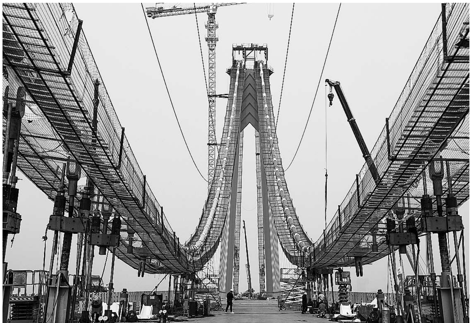
济南凤凰黄河大桥按照双向八车道一级公路标准建设,采用“公轨同层,轨道居中”的设计方案,计划今年10月份建成通车,是济南市“北跨”发展建设黄河新区的重要组成部分。该大桥创多项世界之最,其中主桥梁宽61.7米,宽度是同类型桥梁中的世界第一。图为8月13日,济南凤凰黄河大桥正在加紧施工。徐丹摄/光明图片
