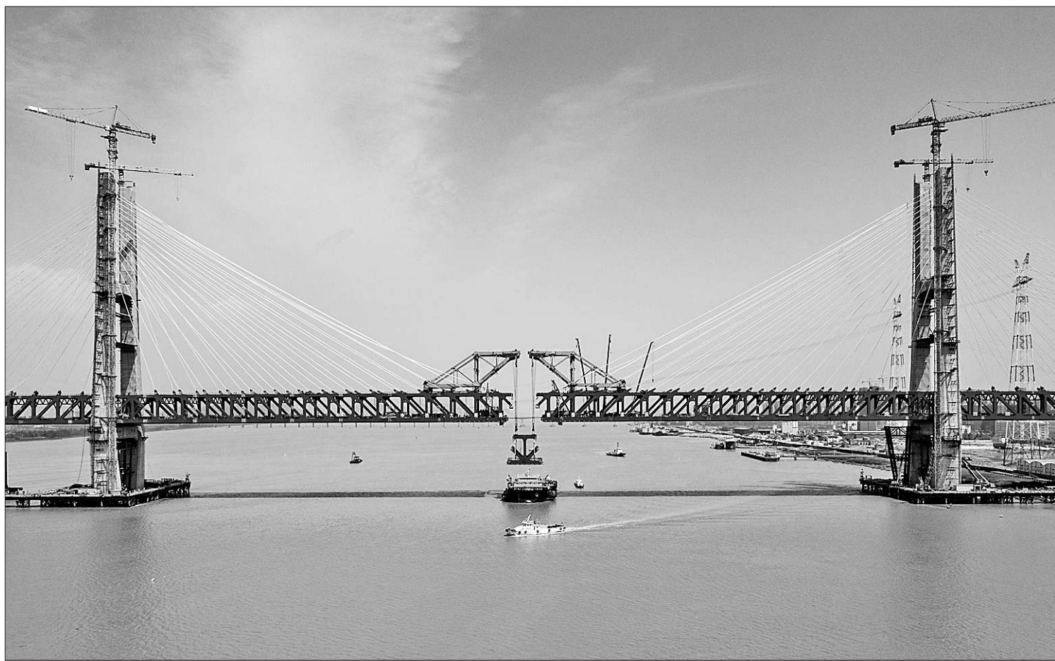
杭绍台铁路椒江特大桥顺利合龙 4月17日,随着最后一块钢梁吊装完成,杭绍台铁路控制性工程椒江特大桥顺利合龙。杭绍台铁路是我国首条民营资本控股的高速铁路项目。该线路连接浙江杭州、绍兴和台州三地,线路设计时速350公里。图为浙江台州的杭绍台铁路建设施工现场。新华社发(孙金标摄)
