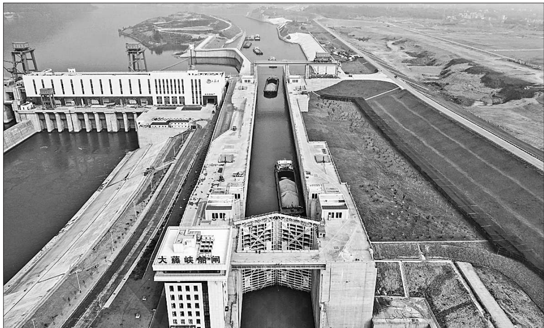
自2020年3月31日试通航以来,广西大藤峡水利枢纽船闸已平稳运行满一年,过往船舶逐步实现大型化,目前累计过闸船舶18030艘次,总核载量超3300多万吨,航运效益明显。图为3月31日,船舶次通过广西大藤峡水利枢纽船闸。
