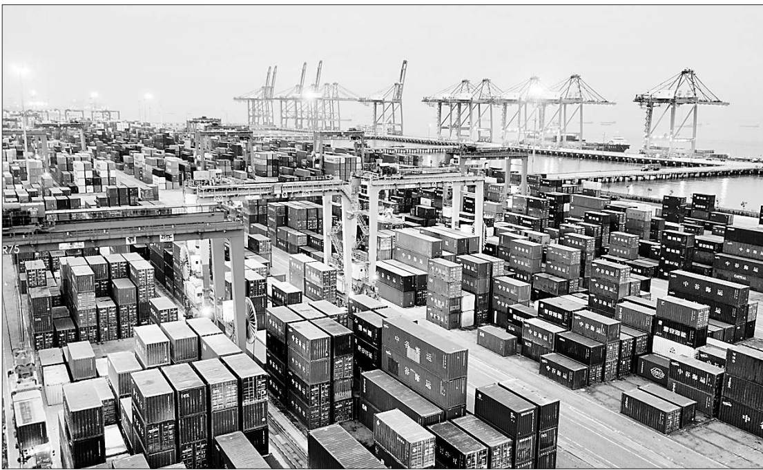
日前,交通运输部公布统计数据显示,江苏省太仓港2020年集装箱吞吐量逆势上扬,全年吞吐量达521万标箱,跻身全国港口吞吐量第九,箱量和名次均创历史新高。图为1月31日,太仓港集装箱码头桥吊,集装箱卡车作业繁忙。 计海新摄/光明图片
