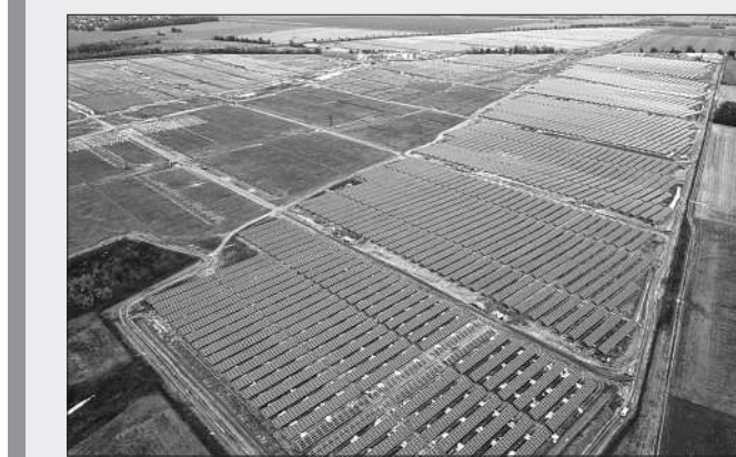
图为10月30日在匈牙利西南部拍摄的由中国通用技术集团中机公司承建的考波什堡光伏电站。
