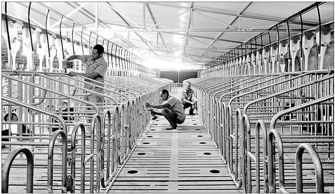
今年以来,四川眉山仁寿县通过加大资金、用地和用电支持,鼓励社会资本自建或与合作新建标准化养猪场,助推生猪产业扩产提质。目前,全县开工新建生猪代养场431个单元,已建成投产103个单元。图为8月21日,工人们在仁寿县宝马镇高照村一家生猪代养场,加装设备调试,确保8月底投产。
