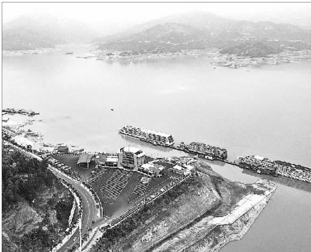
三峡水库试验性蓄水启动 三峡水库9月10日正式启动了2019年175米试验性蓄水。本次起蓄水位146.73米,距离175米正常蓄水位28.27米,待蓄库容约213亿立方米。图为9月10日,湖北省秭归县秭归港正在蓄水。 郑家裕摄/光明图片
