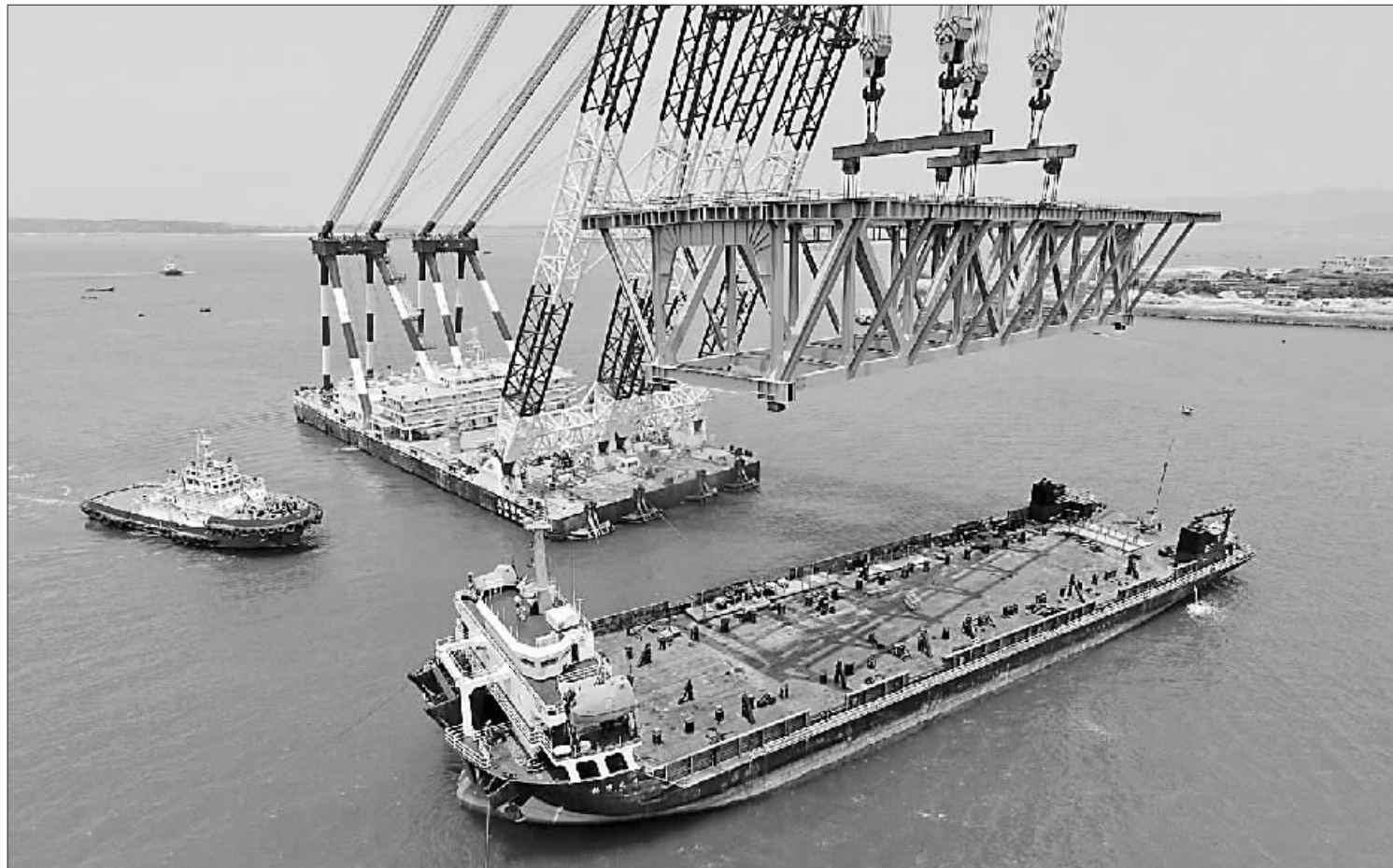
平潭海峡公铁两用大桥全桥非通航孔钢桁梁日前全部架设完成。
