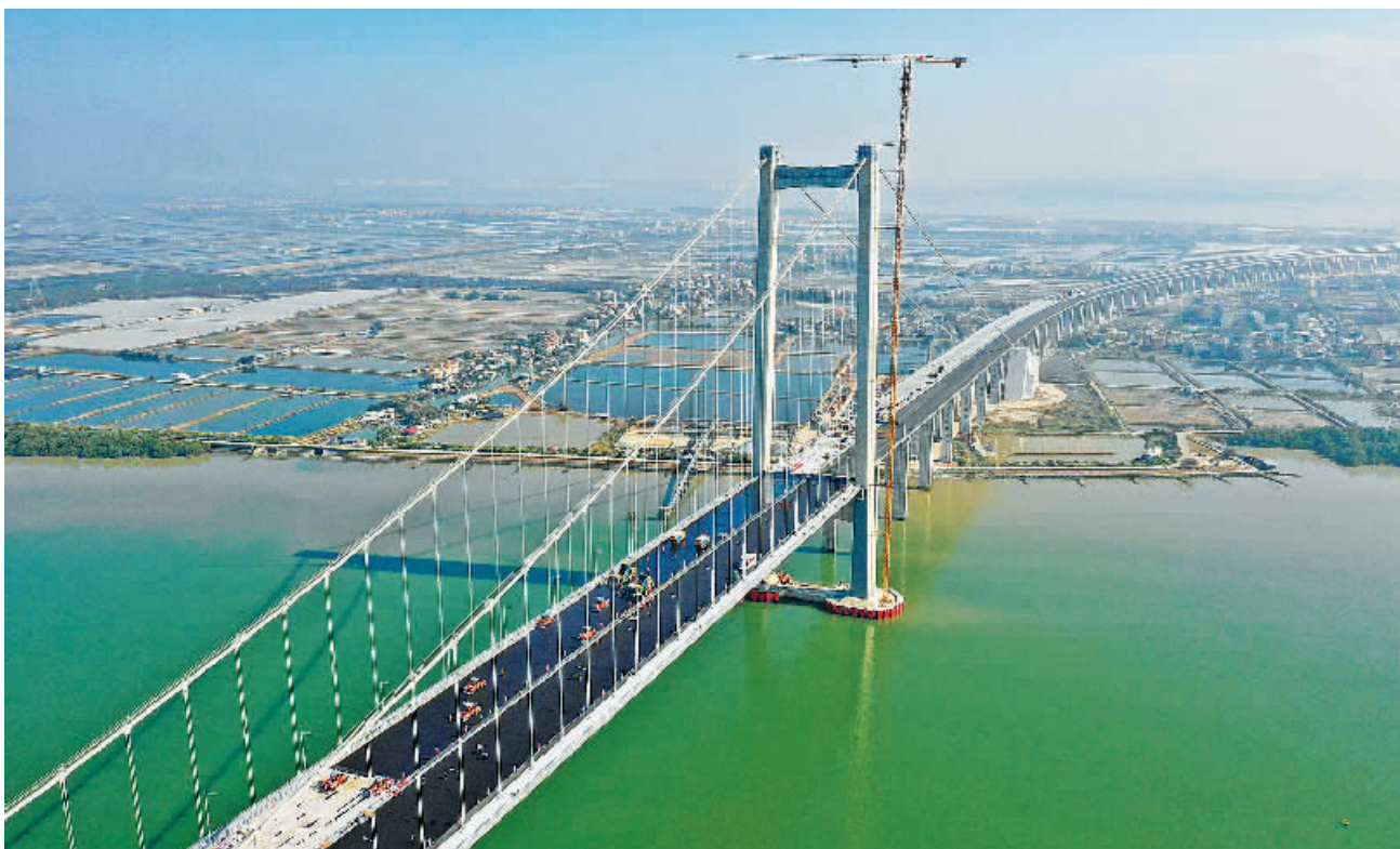
近日，粤港澳大湾区重要过江通道虎门二桥的两座主钢桥面环氧沥青铺装工程完成，预计今年5月1日前通车，届时将有效缓解虎门大桥的通行压力。图为建设中的虎门二桥。 岳路建摄 光明图片/视觉中国
