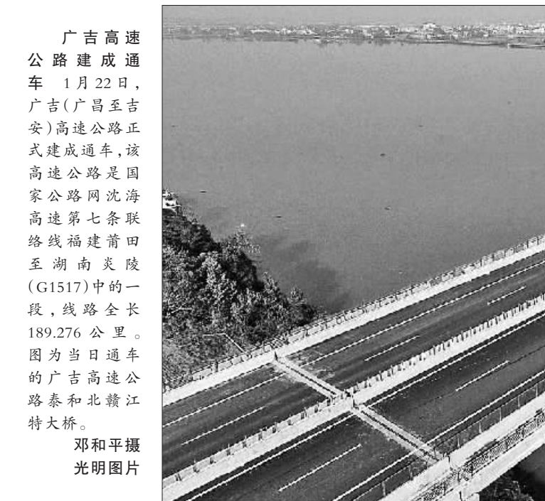
广吉高速公路建成通车 1月22日,广吉(广昌至吉安)高速公路正式建成通车,该高速公路是国家公路网沈海高速第七条联络线福建莆田至湖南炎陵(G1517)中的一段,线路全长189.276公里。图为当日通车的广吉高速公路泰和北赣江特大桥。
