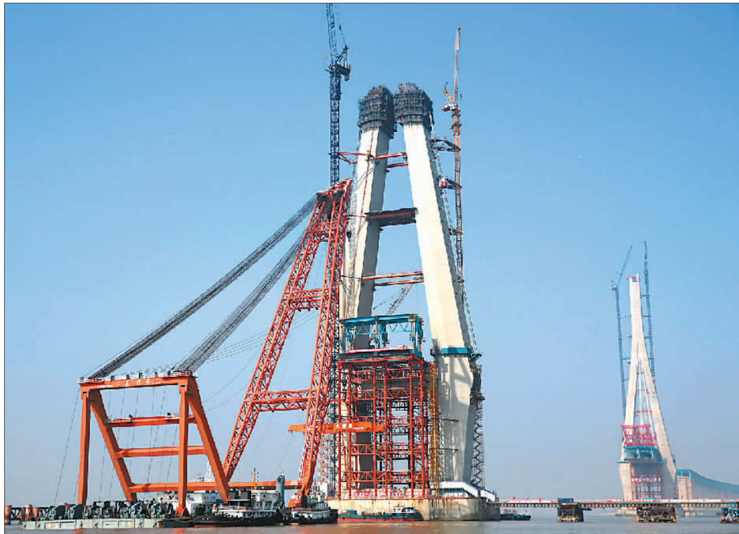
由中铁大桥局承建的沪通长江大桥29号墩首节段钢梁成功架设。
