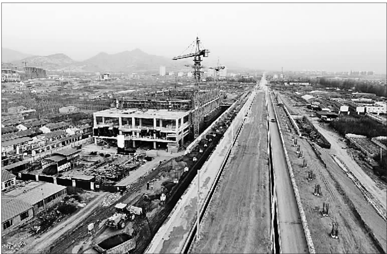
11月20日,北京冬奥会重点配套工程——京张高铁宣化北站主体工程完工。京张高铁东起北京北站,西迄张家口,正线全长174公里,共设10座车站,预计2019年12月底建成通车。图为京张高铁宣化北站主体工程施工现场。
