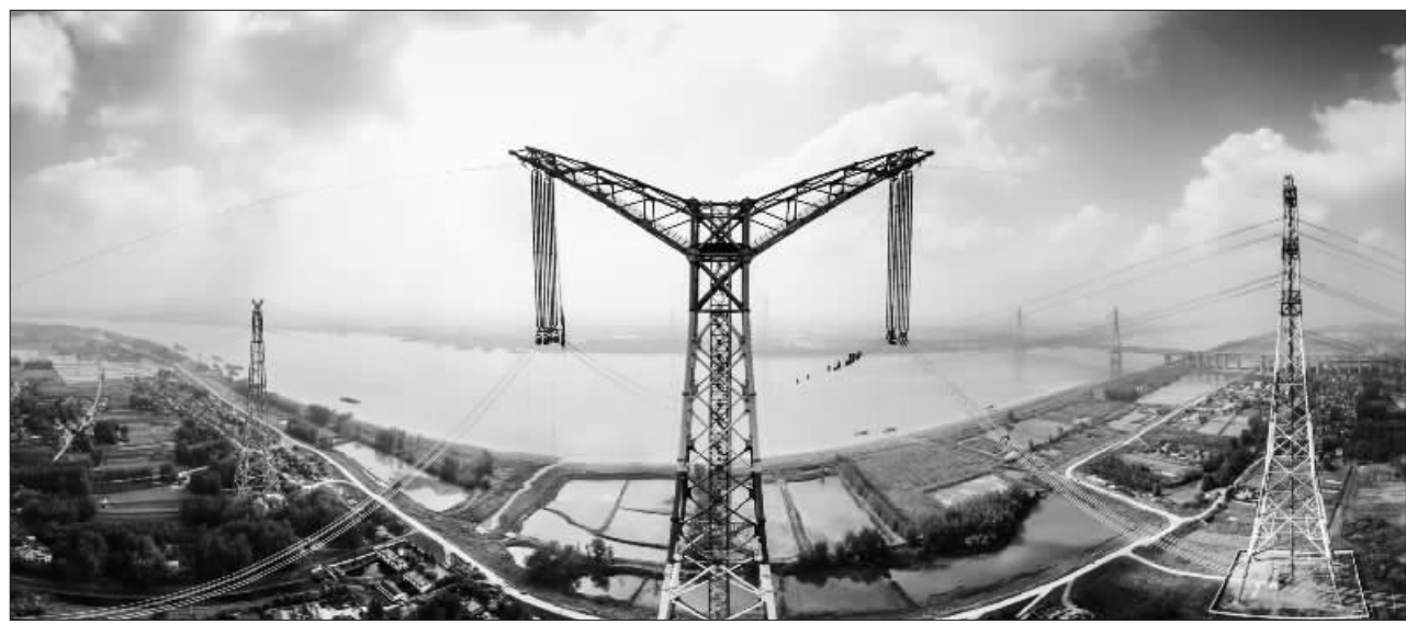
特高压工程跨越长江天堑 4月15日,随着西电东送±1100千伏“新疆准东—安徽皖南”特高压直流工程的最后一相导线顺利跨越长江,世界电压等级最高的特高压大跨越——昌吉特高压长江大跨越工程全线贯通。图为该工程北岸跨越塔。 新华社发
