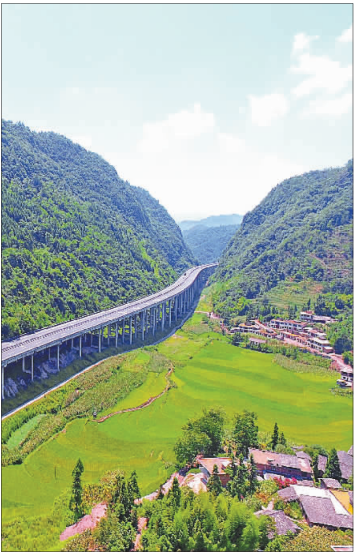
位于四川省叙永县境内的川黔高速金榜特大桥。 李欣摄 光明图片/视觉中国
