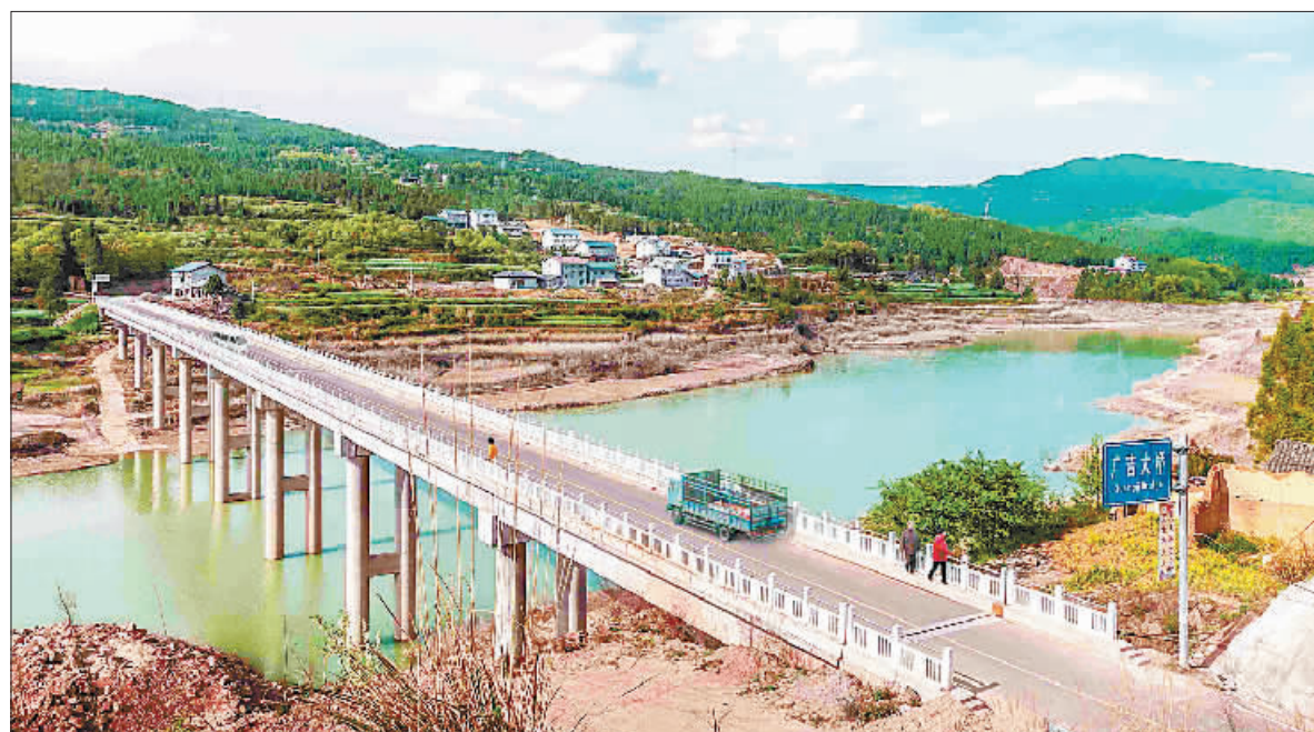
溜索是我国部分偏远山区群众重要的渡河方式。近几年,四川全面推进溜索改桥,让老百姓告别了溜索,踏上了脱贫致富奔小康的新路。图为四川省广元市昭化区广吉村溜索改桥建成的广吉大桥。 新华社发
