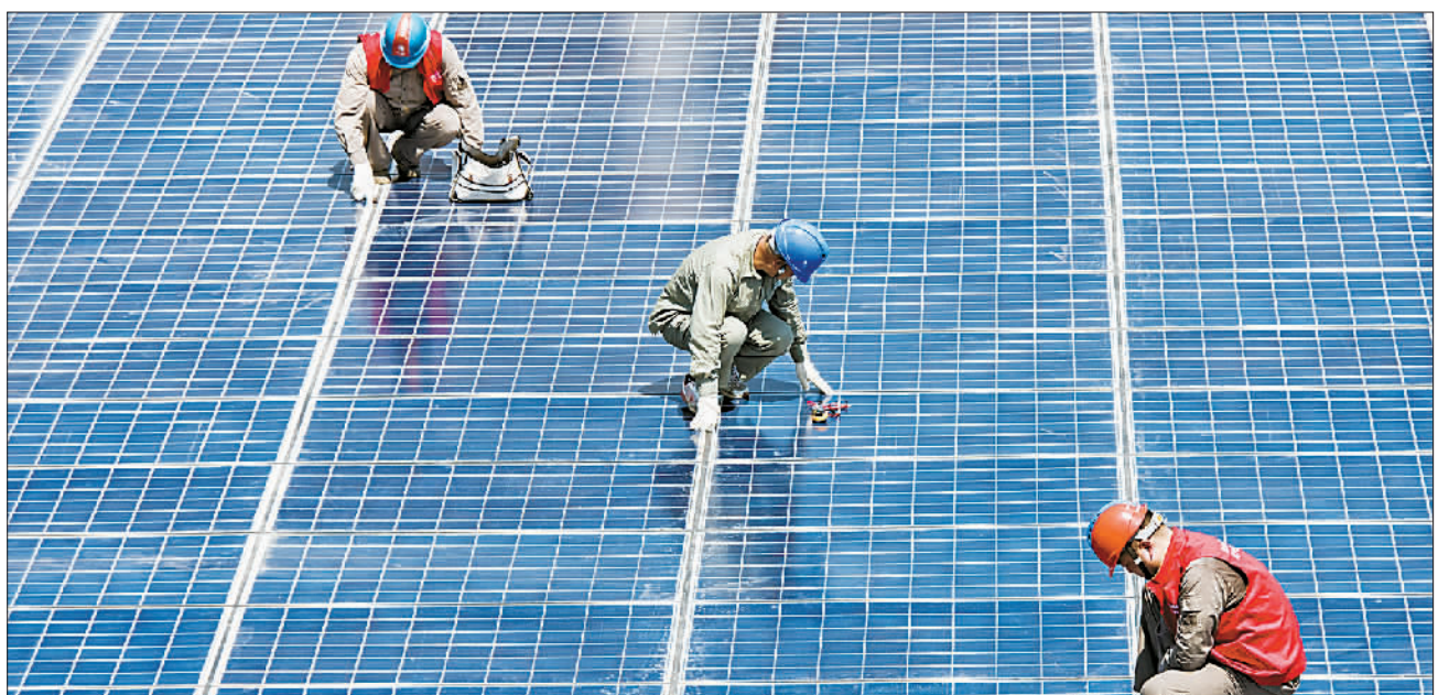
9月2日,湖北省宜昌市秭归县九里经济开发区一装机容量80千瓦的光伏发电项目通过验收并上网发电,成为三峡移民脱贫致富新路。图为供电公司技术人员在对一新建的光伏发电站进行检查验收。 郑家裕摄/光明图片
