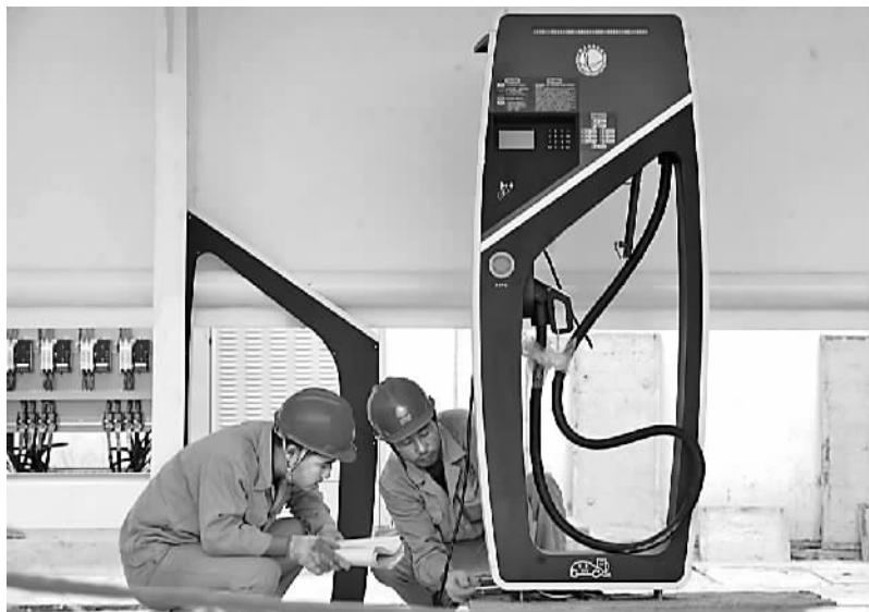
10月3日,工程技术人员在京沪高速铁路江苏扬州沱水服务区新建的电动汽车充电站内安装充电桩。 新华社发
