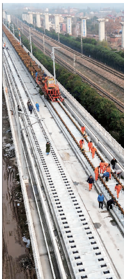
工人们在杭长高铁浙江金华段进行铺轨施工。据介绍,该高铁预计2014年底建成通车,届时杭州至长沙车程将缩短至3小时。新华社记者 谭进 摄
